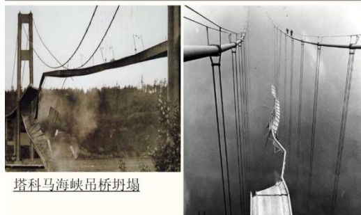
工程案例：塔科马海峡吊桥坍塌
